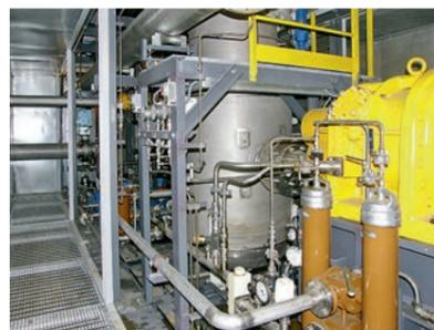
ФОТО 5. Компрессорная установка в арктическом исполнении
