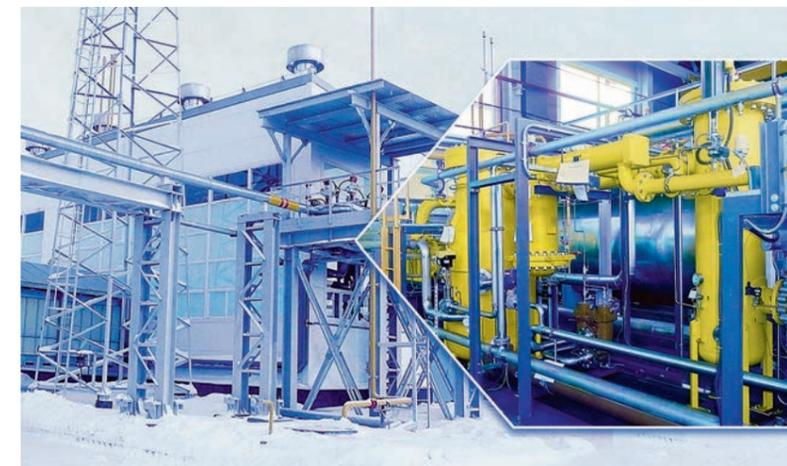
ФОТО 2. Установка подготовки топливного газа «ЭНЕРГАЗ» для ГТЭС-12 Игольско-Талового м/р (ОАО «Томскнефть»)
