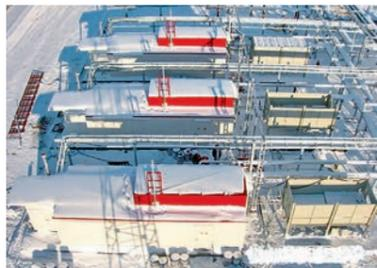
ФОТО 3. КУ низкого давления в составе компрессорной станции Мурьяунского месторождения
