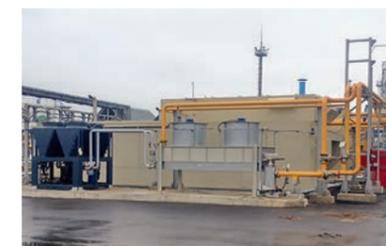
ФОТО 8. Рефрижераторная установка газоохлаждения в составе системы подготовки ПНГ
