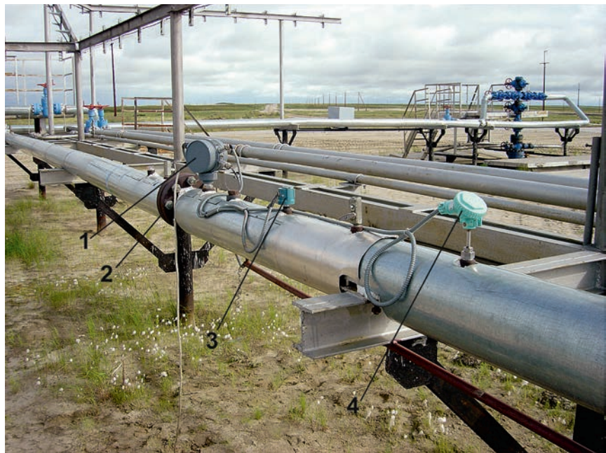
РИСУНОК 2. СИМ системы «Поток-5» с датчиками давления и температуры
