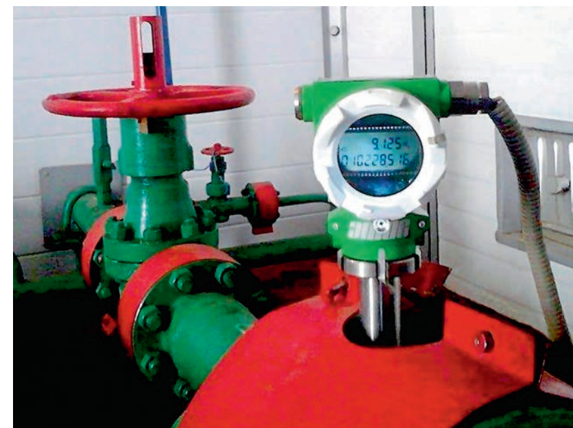
Вихревой расходомер поддержания пластового давления
