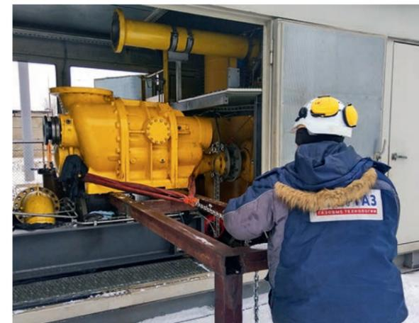
ФОТО 5. Демонтаж оборудования газоподготовки в ходе ремонтных работ на ПГУ-225 Сызранской ТЭЦ
