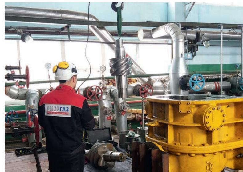
ФОТО 9. Капремонт газового компрессора на Южно-Сахалинской ТЭЦ-1. Работы выполнены в рамках Программы долгосрочного сервиса
