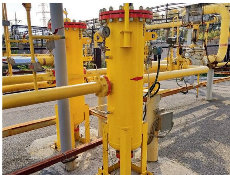
ФОТО 4. В рамках технического переоснащения ГТЭС-25П в Уфе СервисЭНЕРГАЗ установил высокоэффективную систему фильтрации топливного газа
