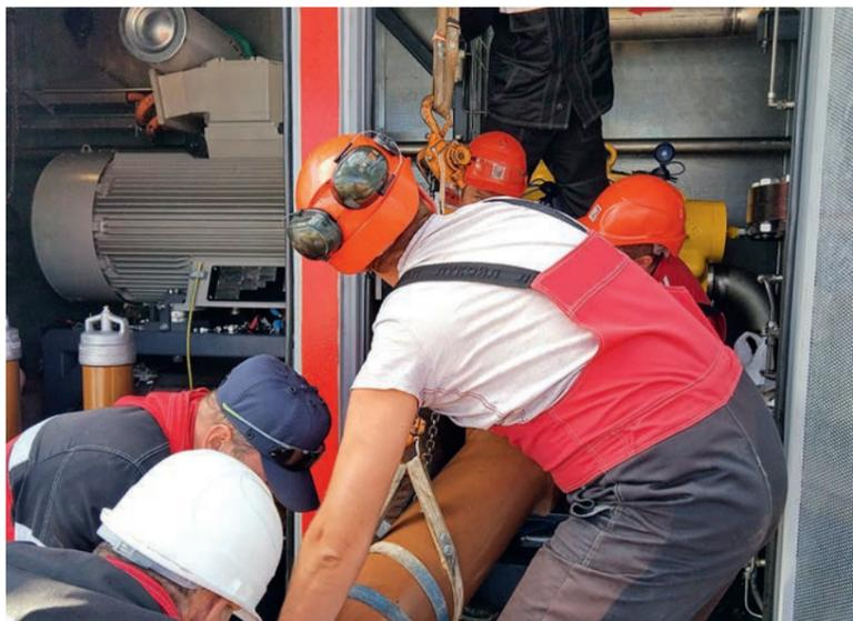
ФОТО 7. Пусковая установка для ГТЭС Восточно-Перевального м/р. Закладка элементов маслосистемы после промывки и модернизации
