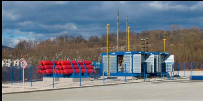
АГНКС блочного (блочно-модульного) исполнения предназначена для заправки автомобилей природным газом, сжатым до давления 20,0 МПа. В зависимости от величины входного давления и от требуемой производительности АГНКС могут оборудоваться компрессорами разной мощности. Для возможности заправки передвижных автомобильных газозаправщиков (ПАГЗ) до давления 25,0 МПа АГНКС может быть дополнительно оборудована газораздаточной колонкой для его заправки.
