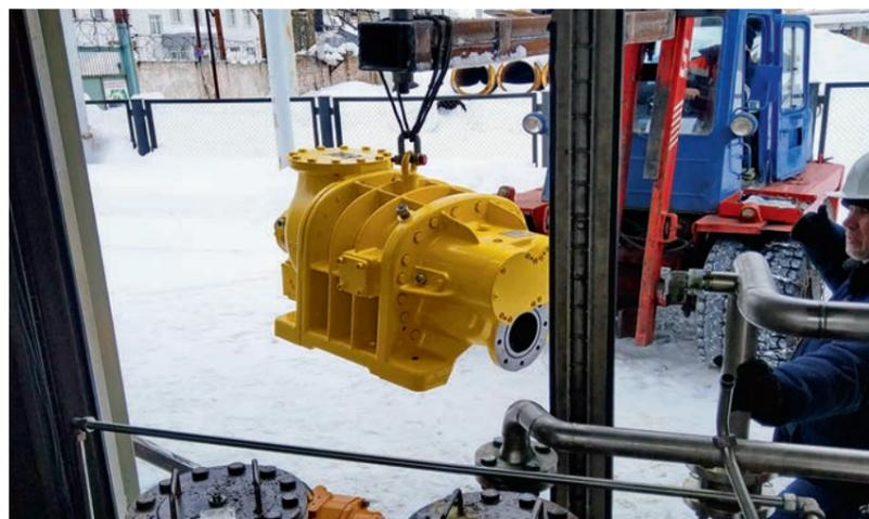
ФОТО 6. Монтаж компрессора, модернизированного с учетом новых условий эксплуатации
