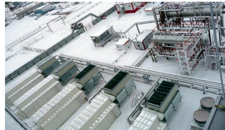
ФОТО 4. Алехинское месторождение (Сургутнефтегаз). На компрессорную станцию низких ступеней сепарации поступает смешанный ПНГ из нескольких источников
