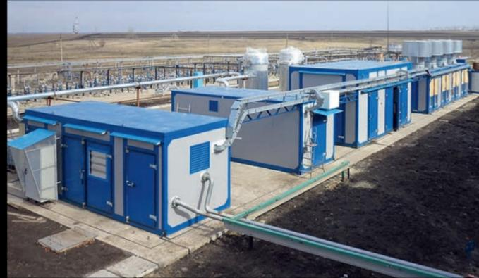
Установки представляют собой компрессорные станции, рассчитанные на обеспечение сжатым воздухом или азотом технологических процессов с расходом сжатого воздуха до 400 м³/мин., при рабочем давлении 15–55,0 МПа.
