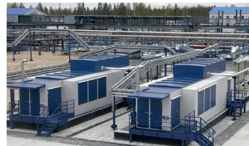
ФОТО 1. Вынгапуровское месторождение (Газпром нефть). Вакуумные компрессорные установки «ЭНЕРГАЗ», спроектированные для низконапорного ПНГ (0,001 МПа)
