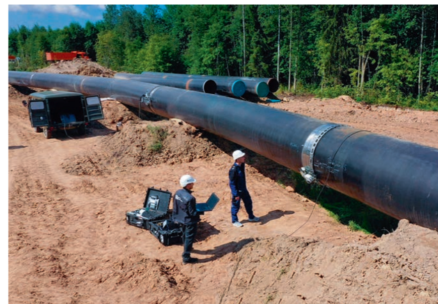
Подготовка к проведению механизированного цифрового рентгеновского контроля
