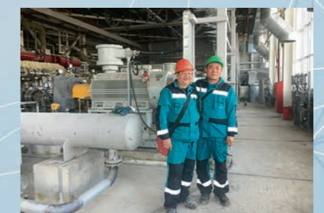
Сервис на площадке Сибур
