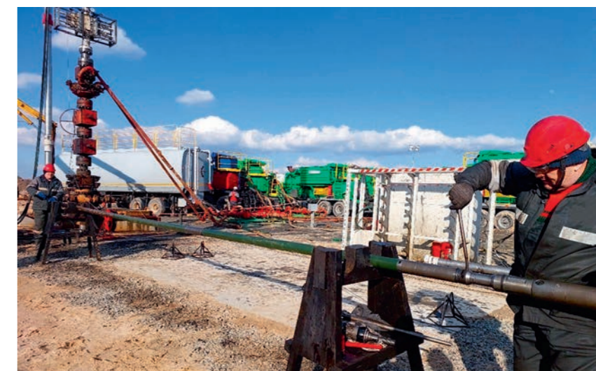
РИСУНОК 9. Работы МГРП по технологии Р&Р на месторождении – подготовка геофизической КНК с перфоратором и пакер-пробкой к спуску в скважину
