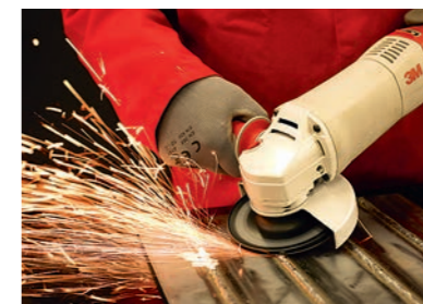
РИС. 3. Зачистка сварного шва фибровым кругом 3М™ Cubitron™ II
