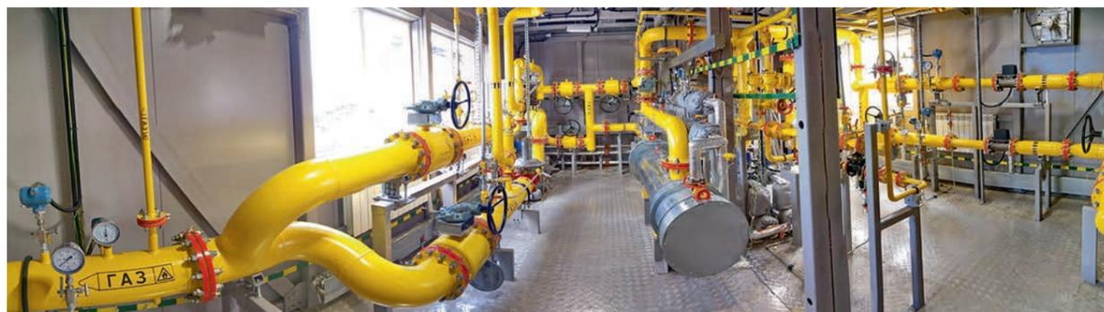
ФОТО 3. Технологический отсек установки подготовки ПНГ для энергокомплекса Барсуковского месторождения
