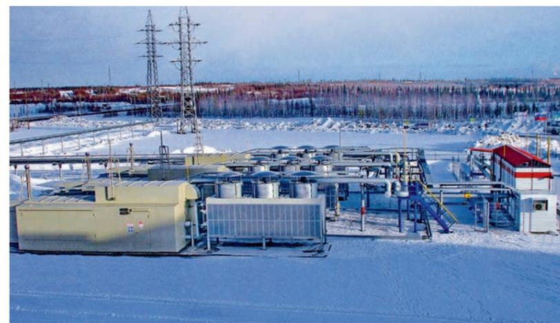
ФОТО 4. Газокомпрессорная станция и блок подготовки попутного газа для ГТУ-ТЭЦ Усинского месторождения
