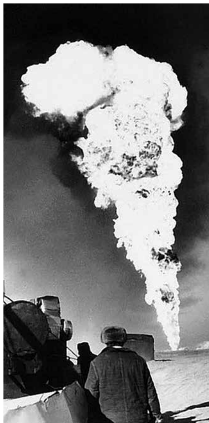
РИС. 5. Аварийное фонтанирование скв. 37–Тенгизской
