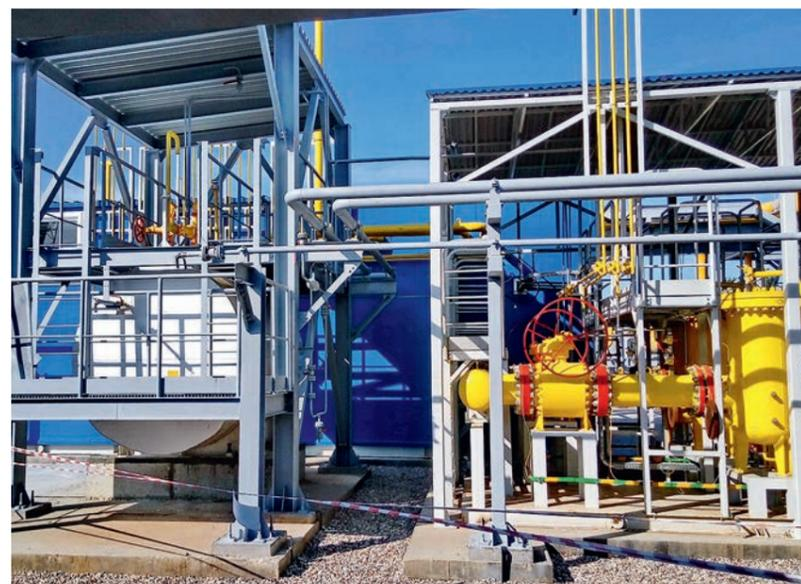
ФОТО 4. Входной блок фильтрации и узел дренажа конденсата ППГ
