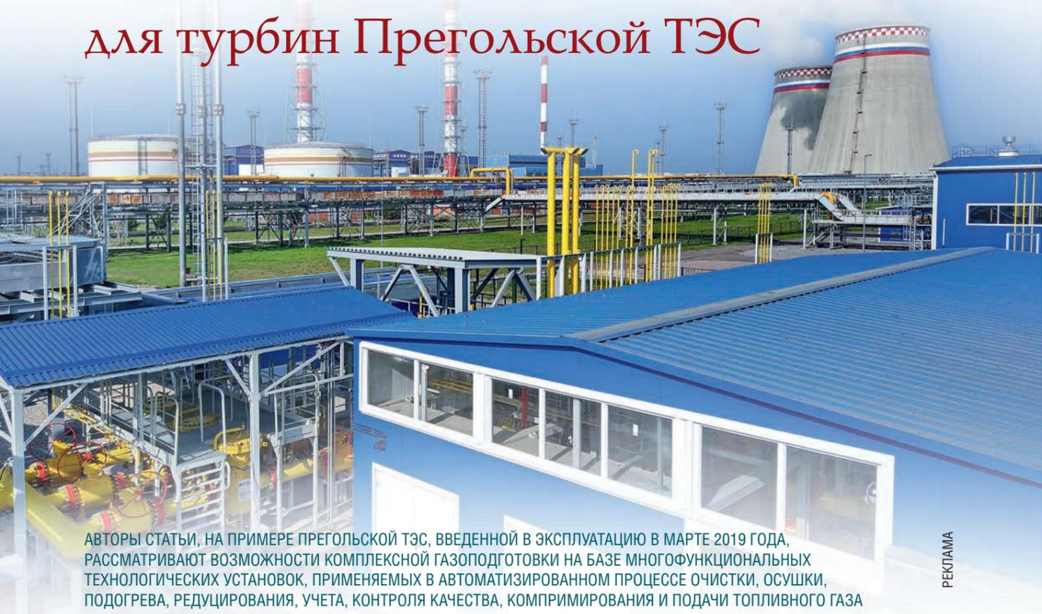
АВТОРЫ СТАТЬИ, НА ПРИМЕРЕ ПРЕГОЛЬСКОЙ ТЭС, ВВЕДЕННОЙ В ЭКСПЛУАТАЦИЮ В МАРТЕ 2019 ГОДА, РАССМАТРИВАЮТ ВОЗМОЖНОСТИ КОМПЛЕКСНОЙ ГАЗОПОДГОТОВКИ НА БАЗЕ МНОГОФУНКЦИОНАЛЬНЫХ ТЕХНОЛОГИЧЕСКИХ УСТАНОВОК, ПРИМЕНЯЕМЫХ В АВТОМАТИЗИРОВАННОМ ПРОЦЕССЕ ОЧИСТКИ, ОСУШКИ, ПОДОГРЕВА, РЕДУЦИРОВАНИЯ, УЧЕТА, КОНТРОЛЯ КАЧЕСТВА, КОМПРИМИРОВАНИЯ И ПОДАЧИ ТОПЛИВНОГО ГАЗА К ТУРБИНАМ ПАРОВАЗОВЫХ ЭНЕРГБЛОКОВ
