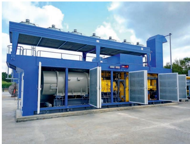
ФОТО 7. Компрессорная установка №1 в составе ДКС топливного газа
