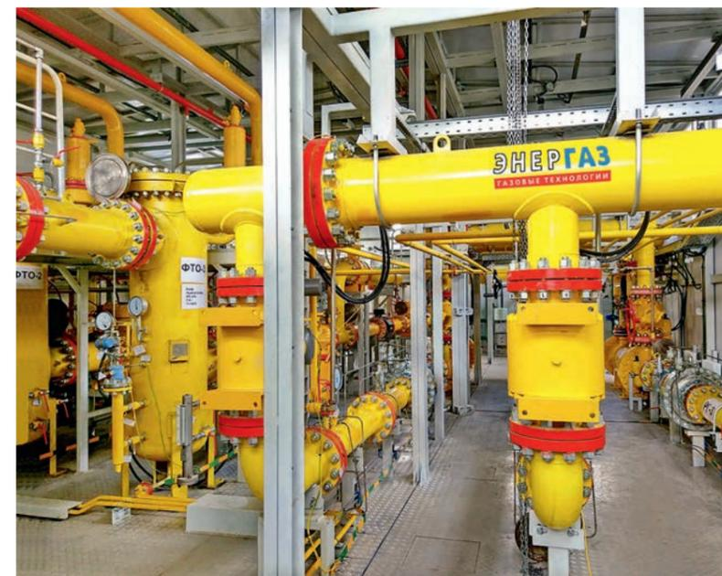
ФОТО 5. Технологические отсеки пункта подготовки газа «ЭНЕРГАЗ»
