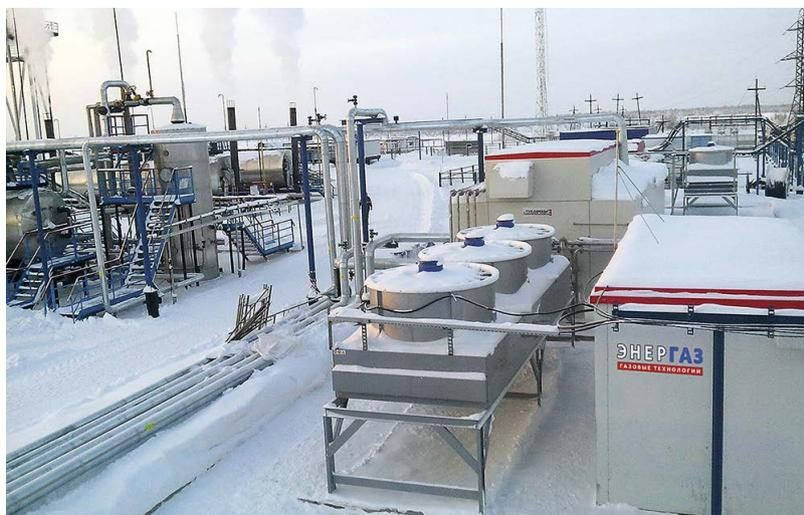
ФОТО 5. Компактная система подготовки ПНГ (осушитель газа, компрессорная установка, чиллер, узел учета газа) на объекте ОАО «Аганефтегазгеология»
