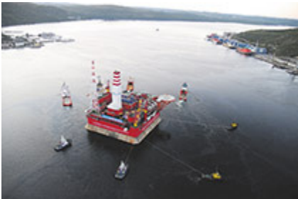
Буксировка МЛСП «Приразломная» после бетонирования (большая осадка) на месторождение
