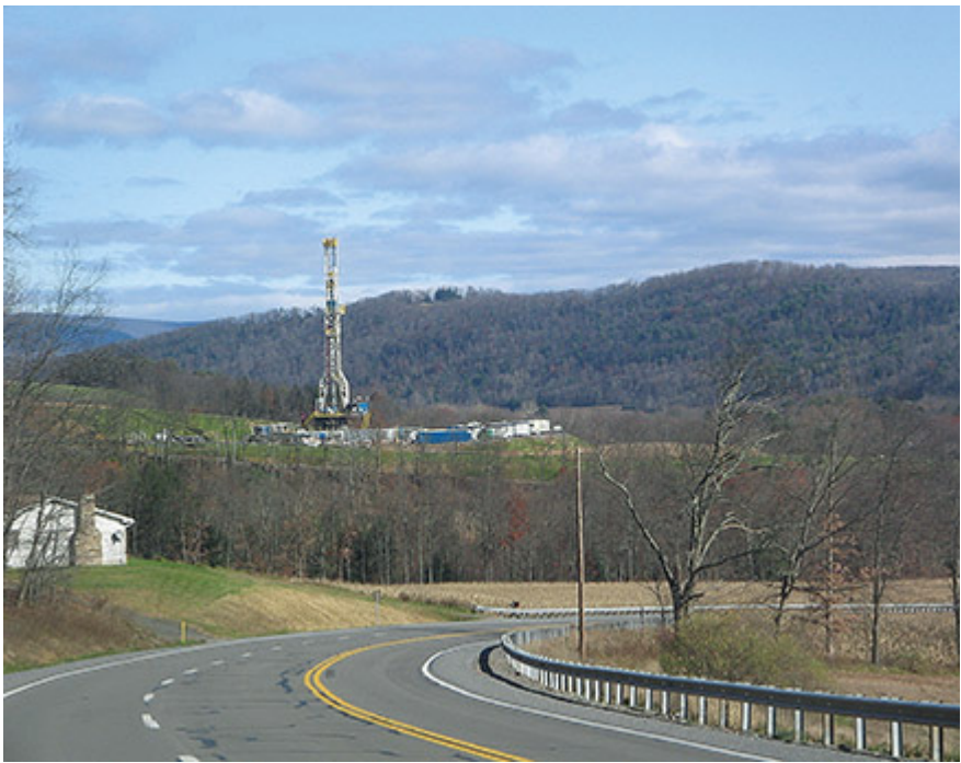
РИС. 1. Буровая на месторождении сланцевого газа в Пенсильвании (США)
