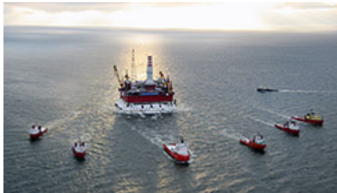
Буксировка МЛСП «Приразломная» до бетонирования (малая осадка)
