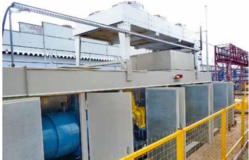
ФОТО 3. ДКС снабжает топливом испытуемые турбины и газоперекачивающие агрегаты
