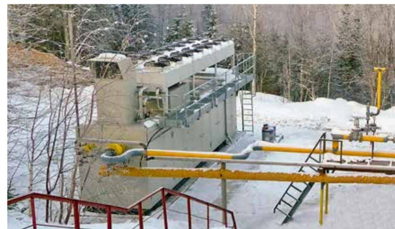
ФОТО 5. Дожимная компрессорная станция «ЭНЕРГАЗ» для стенда «Протон-ПМ»
