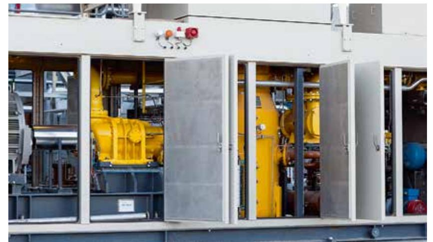
ФОТО 7. ДКС обеспечивает турбины газом с проектными параметрами по чистоте, давлению и температуре
