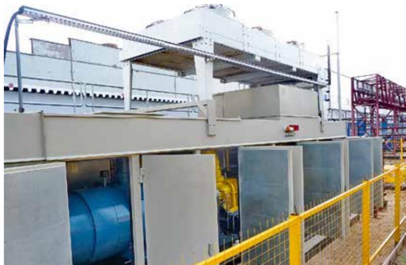
ФОТО 3. ДКС снабжает топливом испытываемые турбины и газоперекачивающие агрегаты
