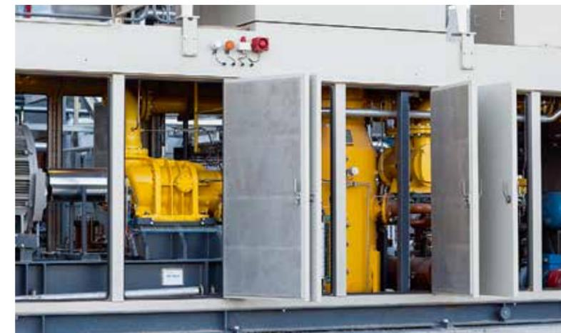
ФОТО 7. ДКС обеспечивает турбины газом с проектными параметрами по чистоте, давлению и температуре
