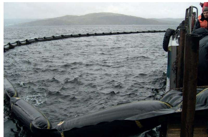
При разливах ННП в акваториях рек, где локализация боннами из-за значительного течения затруднена или вообще невозможна, рекомендуется сдерживать и изменять направление движения нефтяного пятна судами-экранами, струями воды из пожарных стволов катеров, буксиров и стоящих в порту судов.
