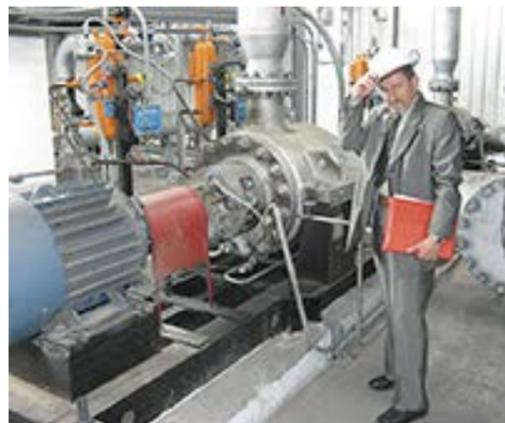
РИС. 6. Насосные агрегаты АНДг 300-100 на установке изомеризации
