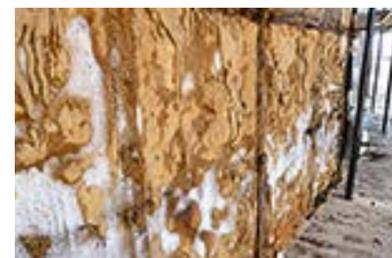
РИС. 2. Промерзание изоляции изотермического резервуара
