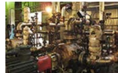
РИС. 8. Насосные агрегаты АНДМг 25-125 на УЗК-60
