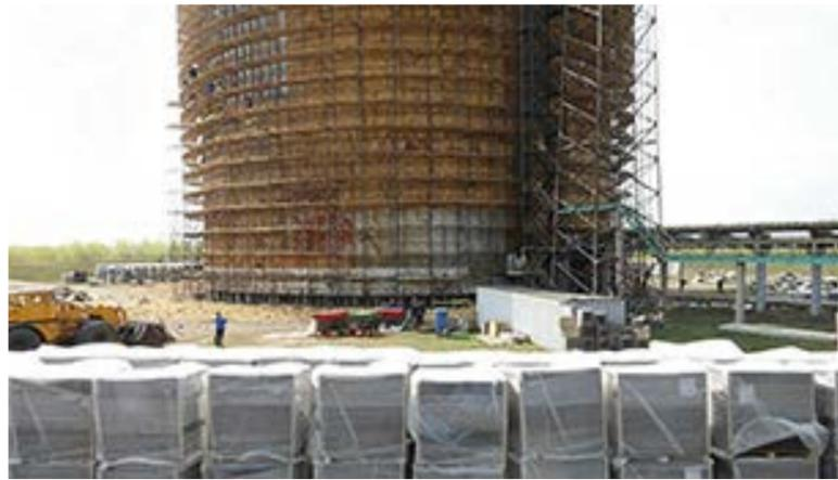
Рис. 4. Демонтаж старой изоляции из ППУ
