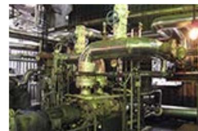
РИС. 7. Насосный агрегат АНДМг 60-350 на УЗК-60
