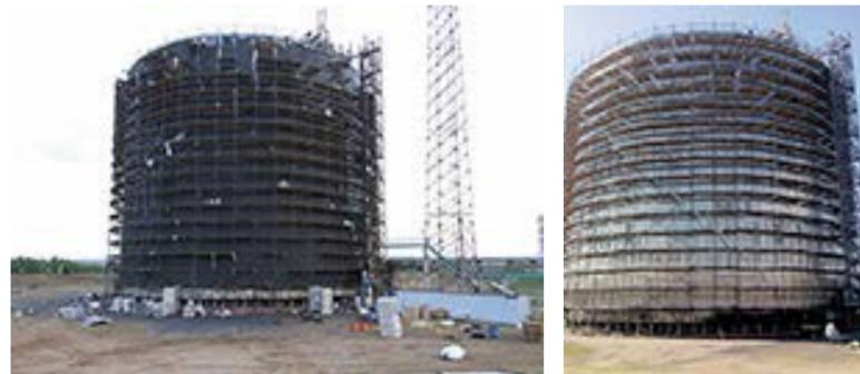
Рис. 5. Монтаж блоков из пеностекла FOAMGLAS® на стену резервуара
