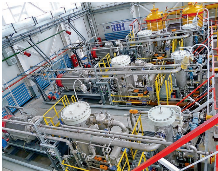
ФОТО 7. Оборудование подготовки и компримирования топливного газа «ЭНЕРГАЗ-Enerproject» для ГТЭС Рогожниковского месторождения
