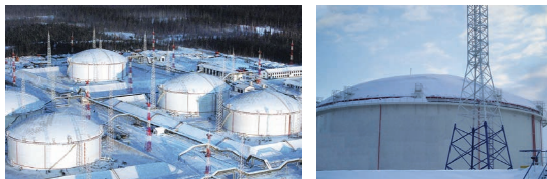
РИС. 1. Скопление снега на крыше РВСПА-50000
