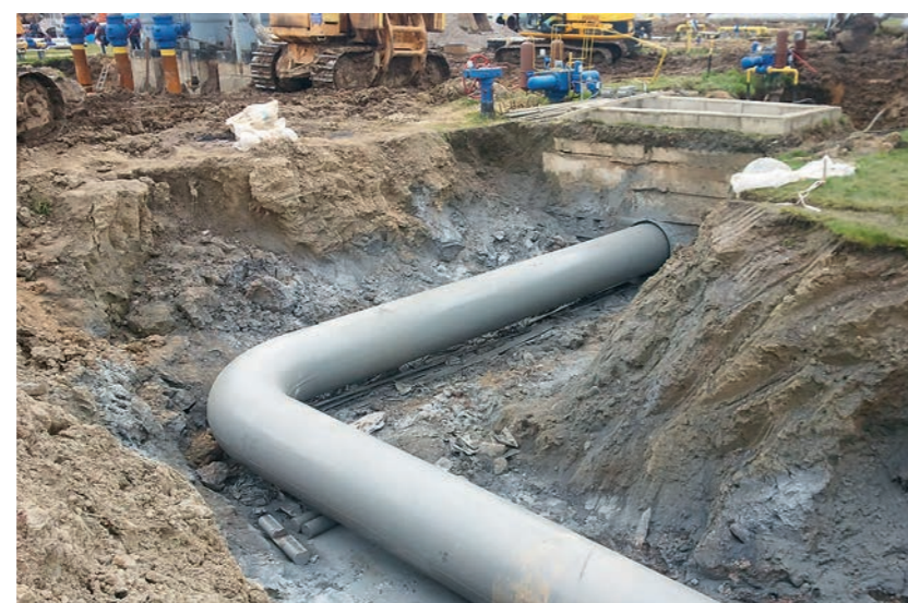
РИС. 1. Нанесенное в трассовых условиях полиуретановое покрытие Scotchkote® 352HT
