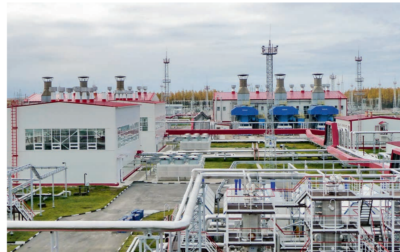
ФОТО 6. Газотурбинная электростанция Талаканского месторождения «Сургутнефтегаза» работает на попутном нефтяном газе
