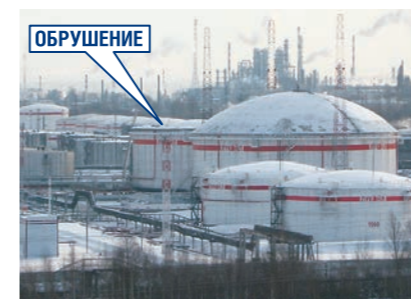
РИС. 3. Разрушение конструкции алюминиевой крыши г. Кстово
