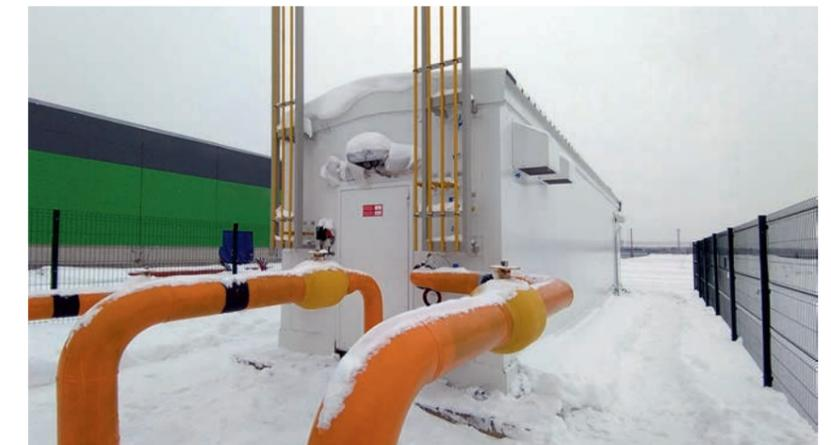
ФОТО 1. Блочный пункт подготовки газа «ЭНЕРГАЗ», действующий на энергоцентре завода НАУАТ
