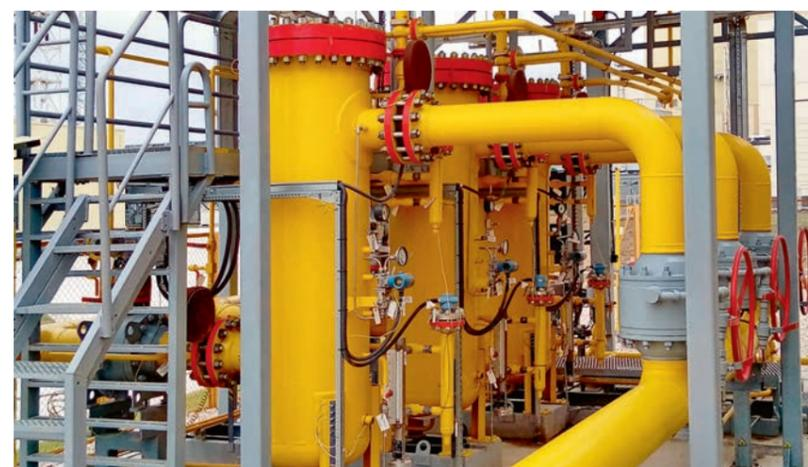
ФОТО 8. Высокоэффективная система газовой фильтрации
