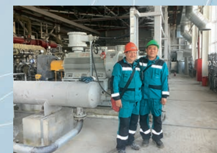
Сервис на площадке Сибур
