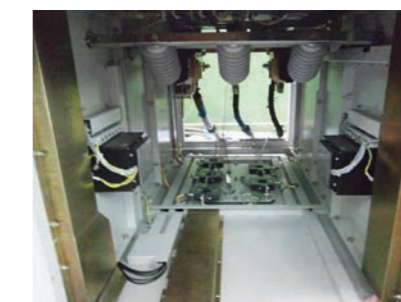
РИС. 8. датчики RFCT в ячейке РУ-6 кВ производства АО «Новая ЭРА»
