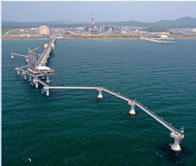
В состав производственного комплекса «Пригородное» входит завод СПГ с двумя технологическими линиями совокупной мощностью в 9,5 млн тонн в год. Газ сжижают по технологии двойного смешанного хладагента, разработанной Shell для сахалинского проекта. Здесь же расположен терминал отгрузки нефти с выносным причальным устройством.
