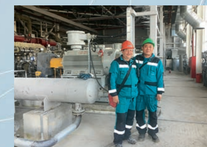
Сервис на площадке Сибур
