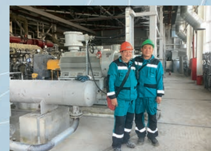
Сервис на площадке Сибур
