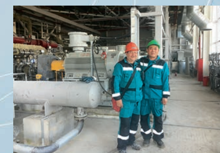
Сервис на площадке Сибур
