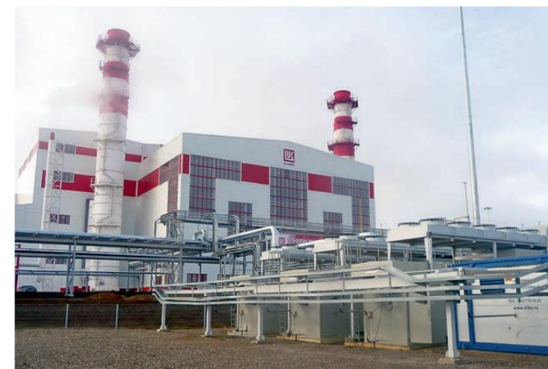
ФОТО 2. Компрессорная станция топливного газа для ПГУ-135 Буденновской ТЭС
