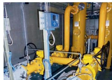
ФОТО 4. БПТГ в составе системы газоподготовки на ГТЭС-25 завода Kastamonu
