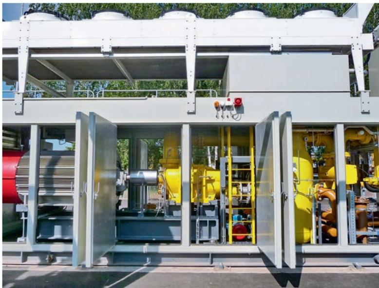
ФОТО 8. Модернизированная газовая компрессорная установка для ПГУ-60 Уфимской ТЭЦ-2
