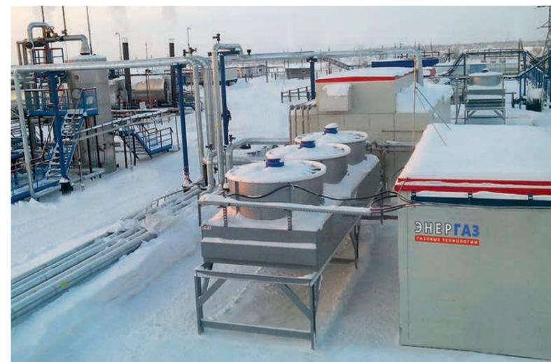
ФОТО 1. Система подготовки попутного газа на ЦПС Западно-Могутлорского месторождения
