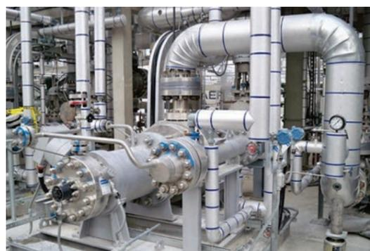
Насосы HERMETIC безотказно работают в самых тяжелых, в том числе и с точки зрения, взрывоопасности и токсичности условиях, при которых недопустимы никакие утечки перекачиваемой среды, в диапазонах:
