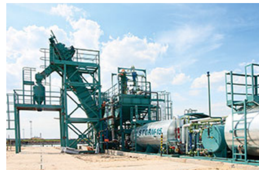
РИС. 1. Комплекс по переработке нефтешламов, производительность: 15 м³/ч
