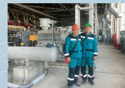
Сервис на площадке Сибур
