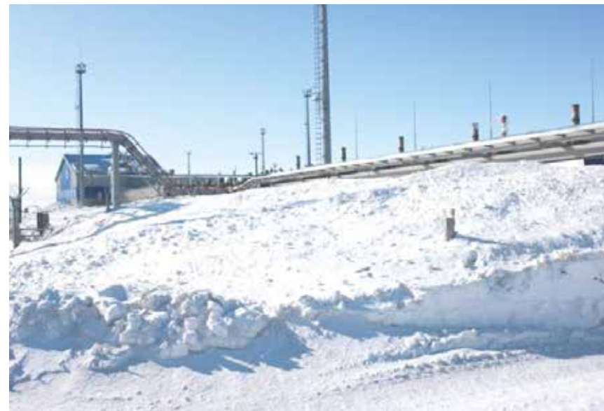
РИС. 10. Пример перераспределения снежного покрова в результате снежных заносов, что в последствии приведет к протаиванию грунта под трубопроводом
