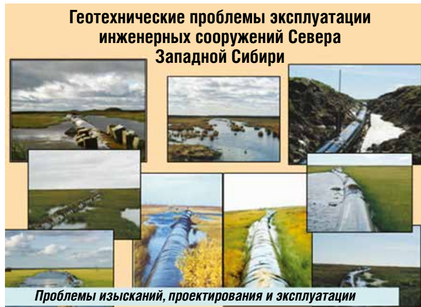
РИС. 9. Примеры разморзания почво-грунтов под нефте- и газопроводами в арктической тундре в условиях вечной мерзлоты
