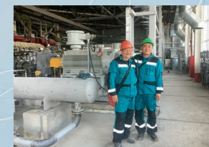
Сервис на площадке Сибур
