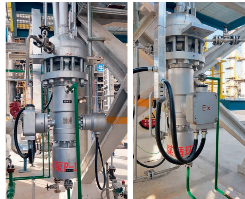
РИСУНОК 3. Эбуляционный насос производства Hefei Huasheng Pumps & Valves Co., Ltd на нефтеперерабатывающем заводе Yulin Refinery (Shaanxi Yanchang Petroleum (Group) Co, Ltd
