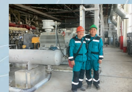
Сервис на площадке Сибур
