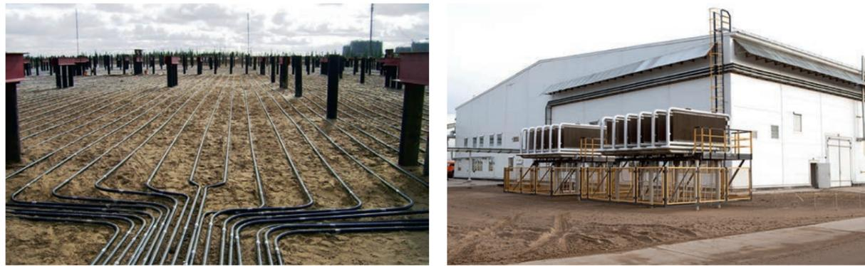
термостабилизации грунтов под сооружениями большой площади или под группами зданий. Система ГЕТ на Ванкорском нефтегазовом месторождении показана на рисунке 4 [16].
