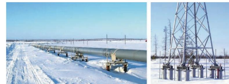
РИС. 4. Подземная часть системы ГЕТ (слева) и конденсаторный блок системы ГЕТ (справа) Ванкорского нефтегазового месторождения [16]
