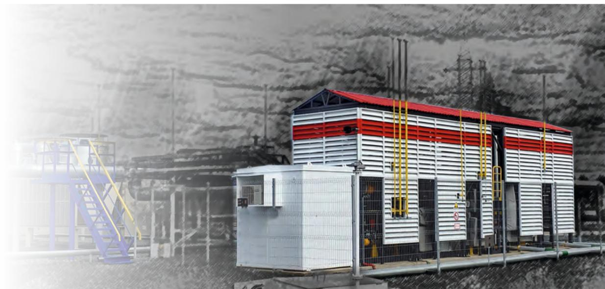
ФОТО 9. БЛОК ПОДГОТОВКИ ПОПУТНОГО ГАЗА ДЛЯ ГТУ-ТЭЦ УСИНСКОГО МЕСТОРОЖДЕНИЯ
