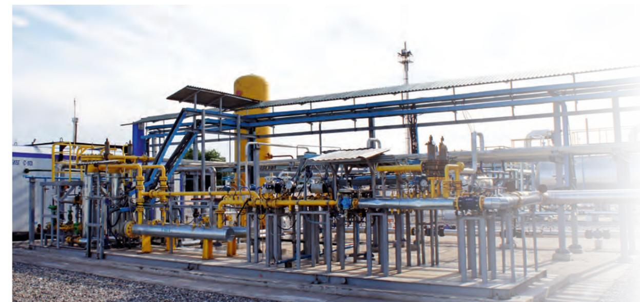
ФОТО 10. СИСТЕМА ПОДГОТОВКИ ТОПЛИВНОГО И ПУСКОВОГО ГАЗА ДЛЯ ГАЗОПЕРЕКАЧИВАЮЩИХ АГРЕГАТОВ ДКС «АЛАН»
