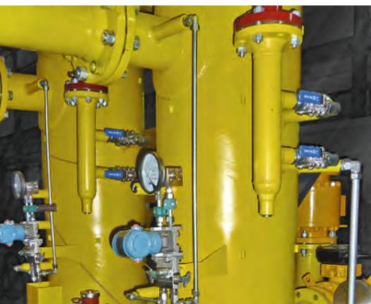
ФОТО 5. ДВУХСТУПЕНЧАТЫЕ КОАЛЕСЦИРУЮЩИЕ ФИЛЬТРЫ-СЕПАРАТОРЫ
