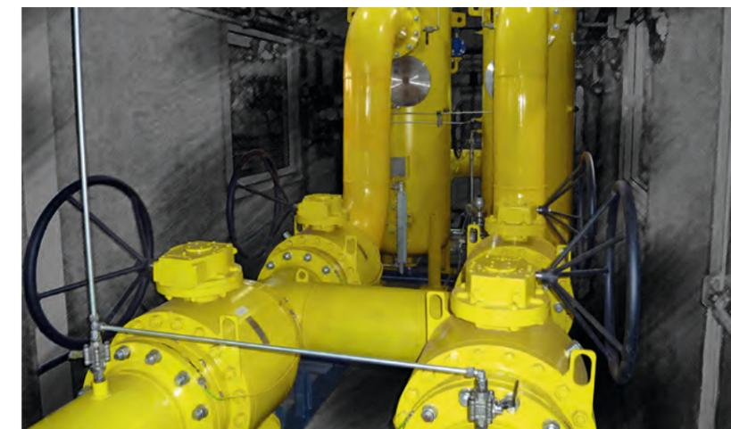
ФОТО 2. ТЕХНОЛОГИЧЕСКИЙ ОТСЕК БЛОЧНОГО ПУНКТА ПОДГОТОВКИ ГАЗА
