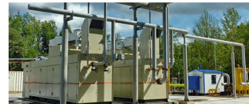
ФОТО 12. СИСТЕМА ГАЗОПОДГОТОВКИ ДЛЯ АВТОНОМНОЙ ГПЭС ЗАВОДА МИКРОЭЛЕКТРОНИКИ «АНГСТРЕМ-Т»
