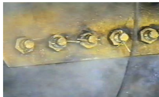
РИС. 10. Фрагмент железнодорожной цистерны после очистки струями TAB
