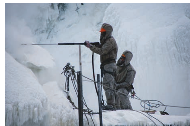
РИС. 4. Поддача струй ТАВ в снежно-ледяную массу
