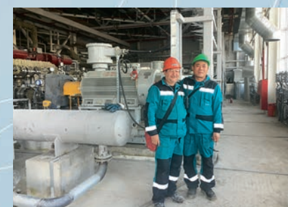
Сервис на площадке Сибур
