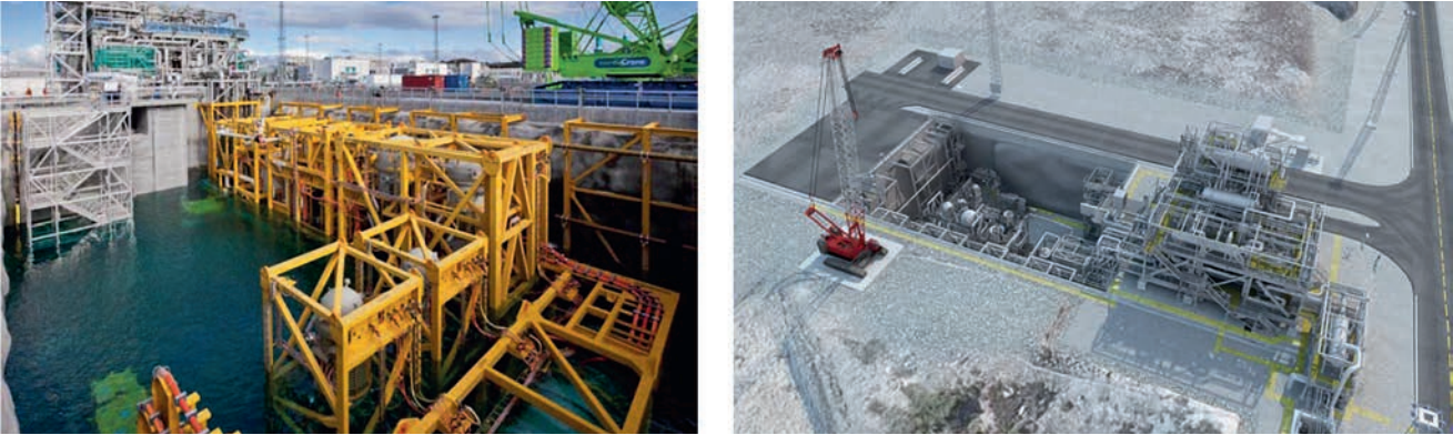
РИСУНОК 3. Общий вид испытательного полигона в Nihamna
