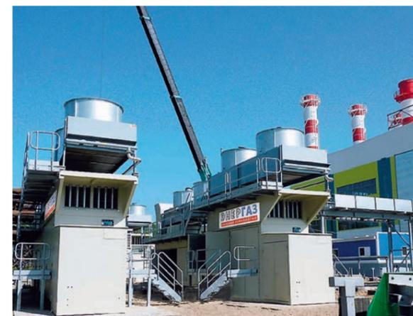
Двухступенчатые ДКУ обеспечивают топливом 4-й энергоблок Южно-Сахалинской ТЭЦ-1
