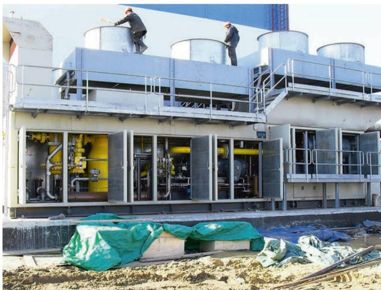
Монтаж аппарата воздушного охлаждения на компрессорную установку
