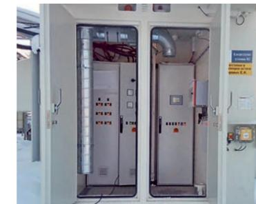
Отсек САУ расположен внутри блок-модуля компрессорной установки
