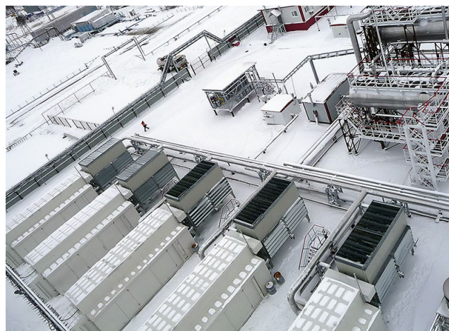
ФОТО 2. Дожимная компрессорная станция Алехинского нефтяного месторождения в эксплуатации
