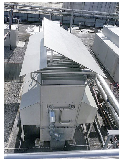
ФОТО 4. Аппарат воздушного охлаждения после модернизации системы теплообмена ДКУ
