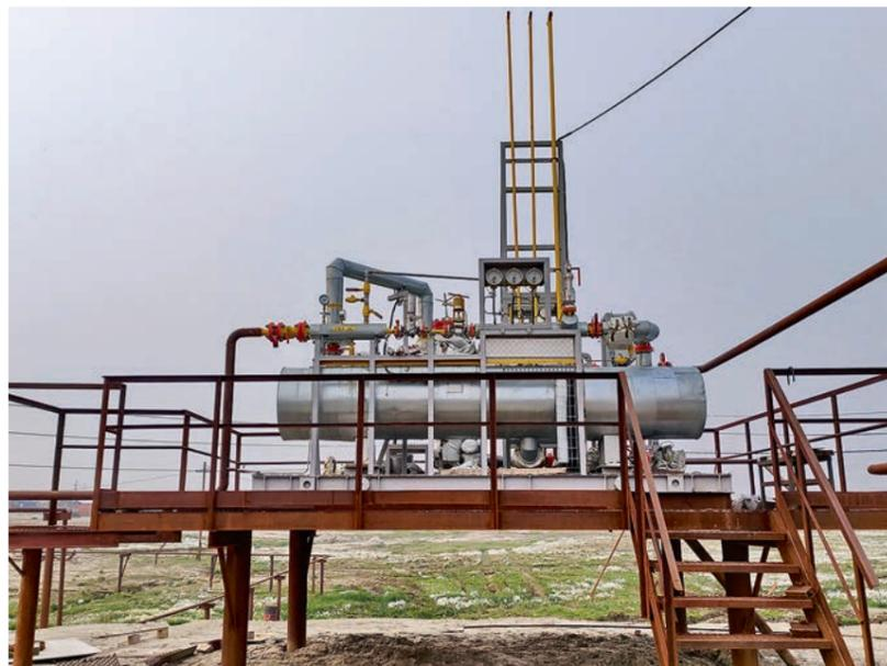
ФОТО 3. Модуль подготовки топливного газа №1 на площадке энергоцентра Харасавэйского месторождения
