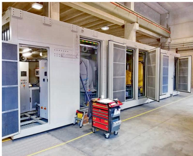
ФОТО 9. Дожимная компрессорная станция для ПГУ-65 Минской ТЭЦ-2 на этапе заводских испытаний
