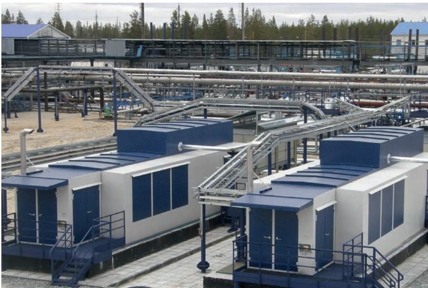
Фото 10. Вакуумные компрессорные установки «ЭНЕРГАЗ» работают на попутном газе с давлением 0,001 МПа
