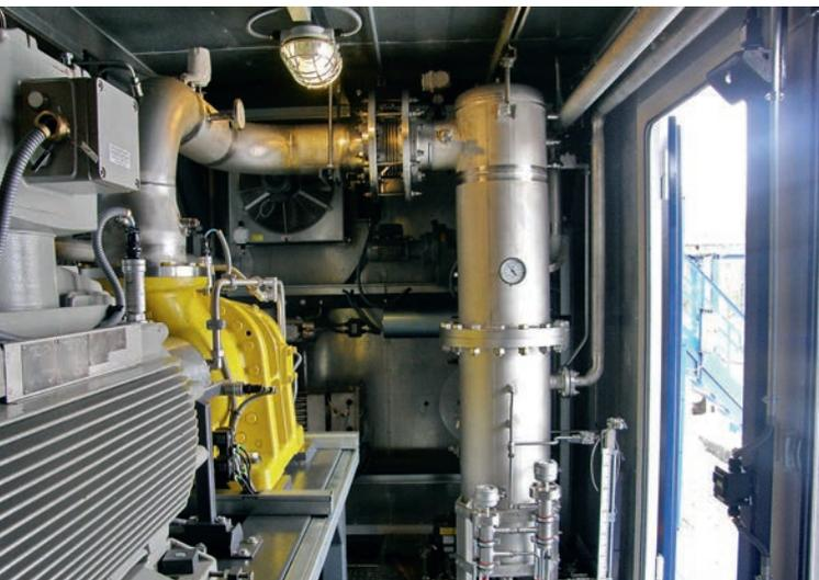
Фото 3. Фильтр-скруббер вакуумной компрессорной установки «ЭНЕРГАЗ» на ДНС-1 Вынгапуровского м/р ОАО «Газпромнефть-Ноябрьскнефтегаз»
