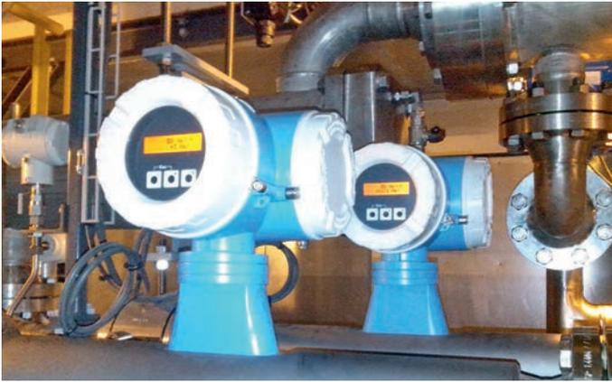
Фото 5. Узел учета компримируемого газа в компрессорных установках
