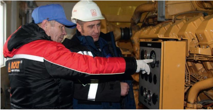
**service** предложили следующее решение: на базе программного обеспечения «IntelliMonitor» марки ComAp создать надежную, открытую, функциональную систему централизованного управления, позволяющую в режиме реального времени с единого диспетчерского пульта автоматически запускать требуемое число генераторных установок, управлять мощностью, разделяя на активную и реактивную, планомерно нагружать и разгружать газопоршневые, дизельные и газотурбинные генераторные установки.
