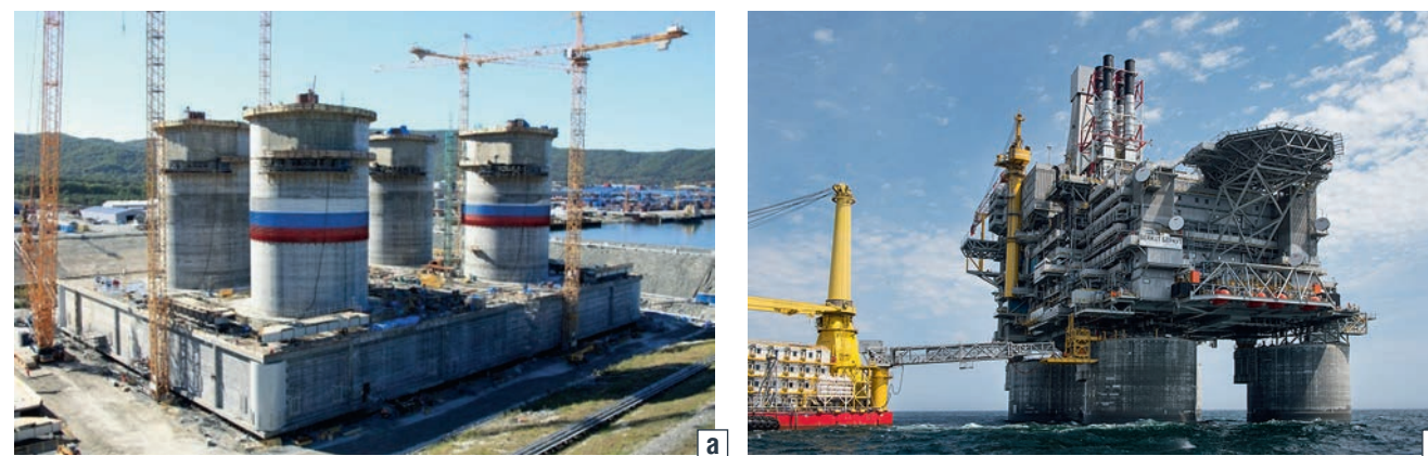
РИСУНОК 3. БОГТ МНГС «Беркут» в сухом доке и в проектном положении на шельфе Охотского моря
