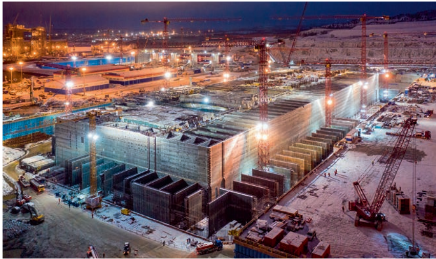
РИСУНОК 4. Наплавной гравитационный опорный блок проекта «Арктик СПГ-2»
