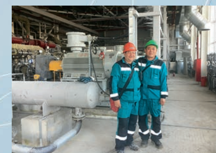
Сервис на площадке Сибур
