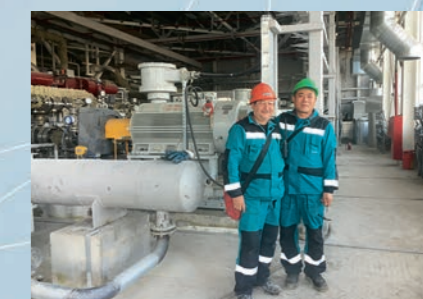
Сервис на площадке Сибур
