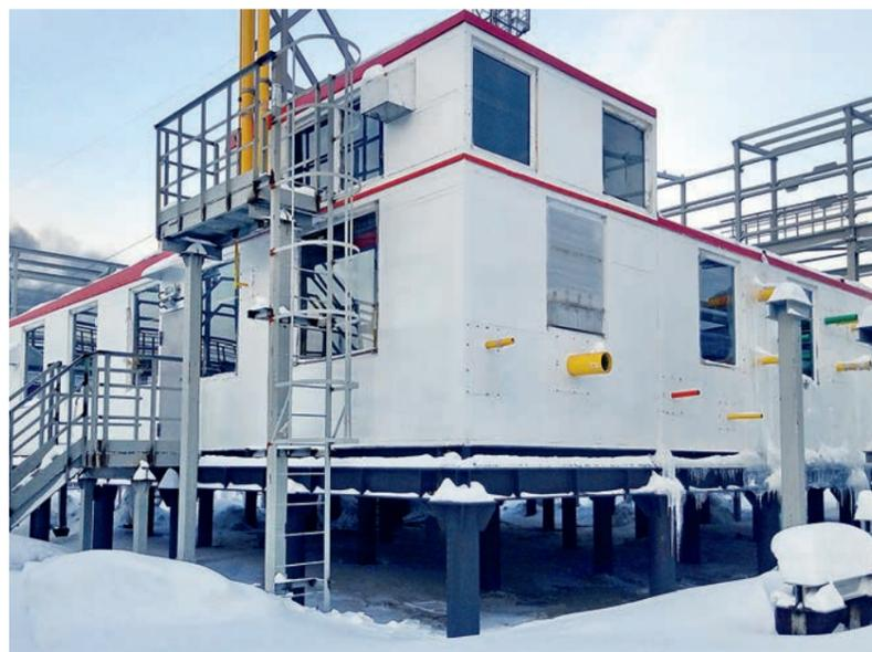
ФОТО 9. Модуль подготовки топливного газа №1 для объектов УКПГиК на Восточном Уренгое
