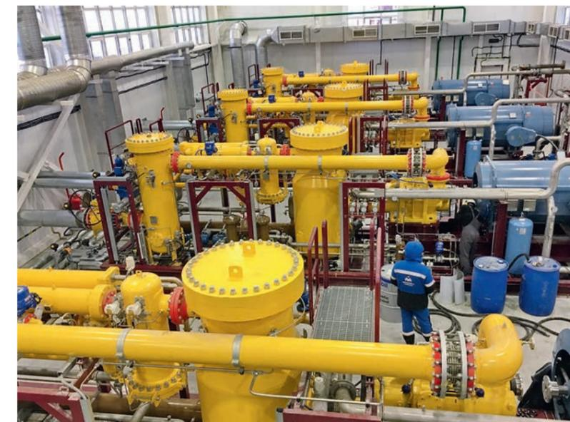
ФОТО 4. Установка подготовки топливного газа для ГТЭС на Мессояхе
