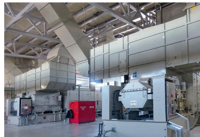
ФОТО 10. Газотурбинные установки Titan 130 производства Solar
