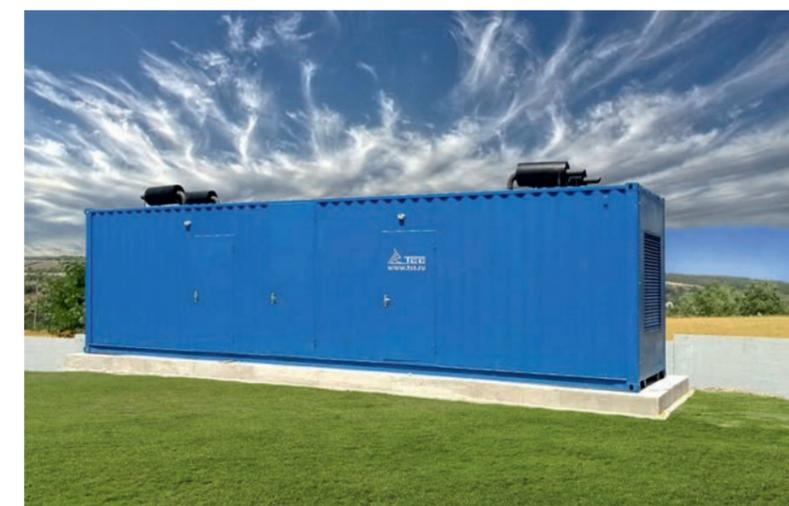
ФОТО 1. Энергокомплекс 1000 кВт в блок-контейнере УБК-12 с дополнительным отсеком
