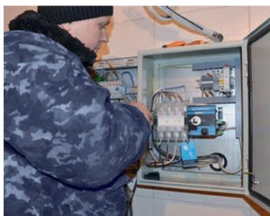
ФОТО 7. Монтаж шкафа AVR (автоматический ввод резерва)
