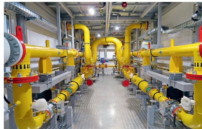
ФОТО 7. Газорегуляторный пункт обеспечит топливом печи прямого нагрева нефти на УПН «Уса-Тяжелая нефть»
