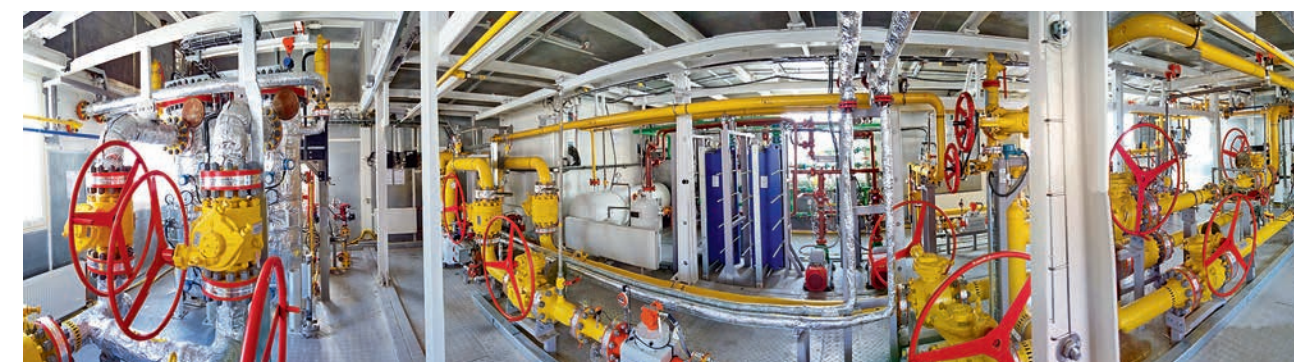
ФОТО 1. Отдельные блок-боксы при монтаже создают общее технологическое пространство многоблочной установки
