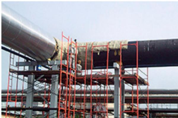
Монтаж второго слоя шумоизоляции из минеральной ваты
