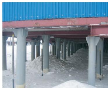
Кроме того, проветриваемое подполье имеют большую материалоемкость за счет большого количества свай и перекрытия, а следовательно, и большую стоимость.
