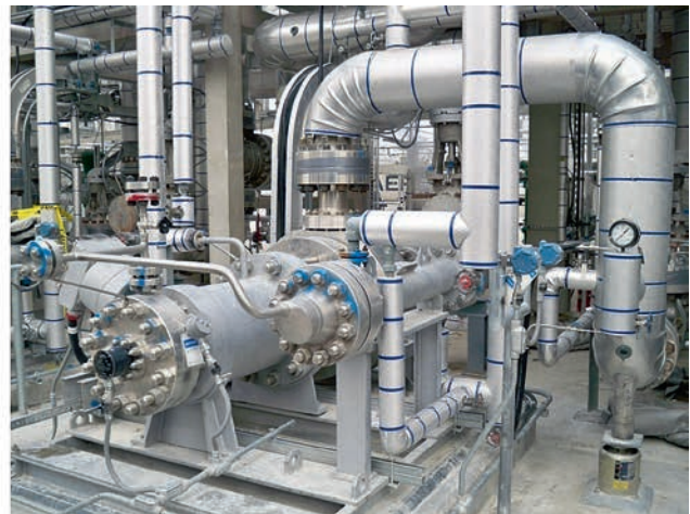
РИС. 4. API 685 – герметичные бессальниковые насосы с экранированным двигателем
