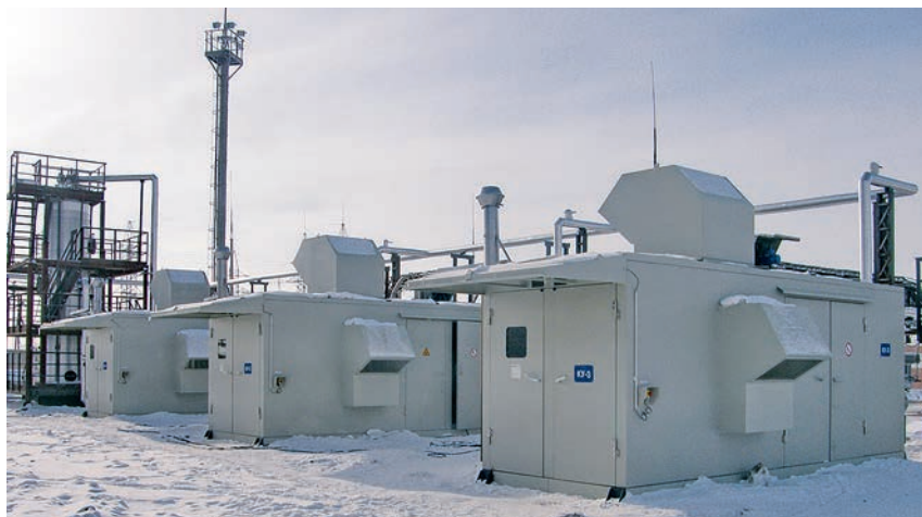
ФОТО 9. Газодожимное оборудование низкого давления на ДНС-2 НГДУ «Комсомольскнефть»
