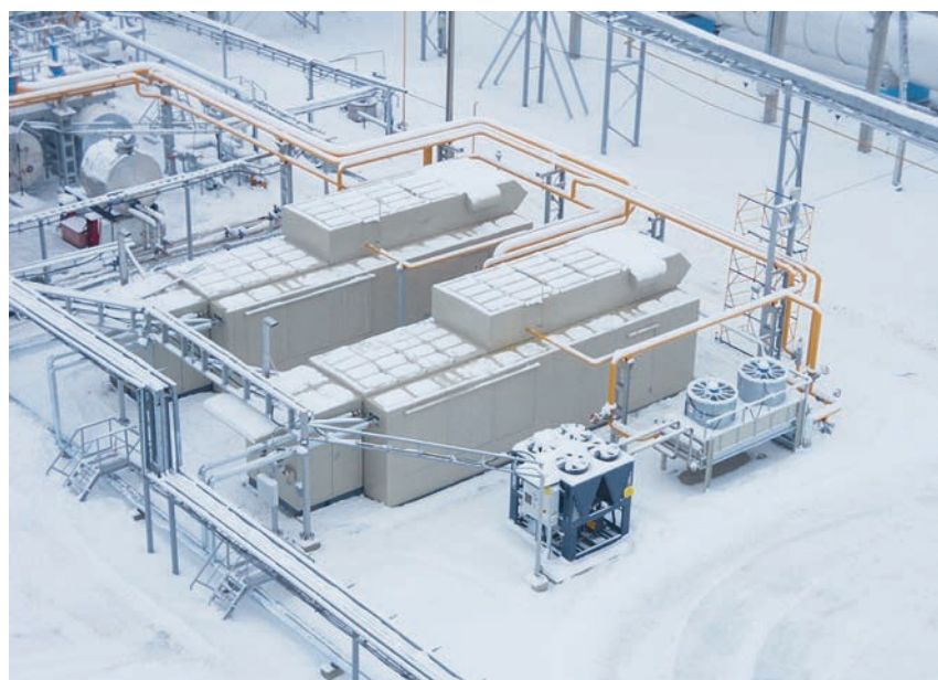
ФОТО 8. Компрессорная станция Речицкого месторождения («Белоруснефть») компримирует низконапорный ПНГ
