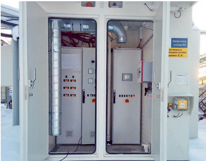
ФОТО 7. Отсек САУ компрессорной установки на КС Мурьянского месторождения
