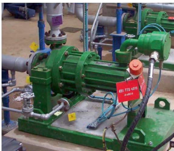
РИС. 6. Многоступенчатые насосы HERMETIC
