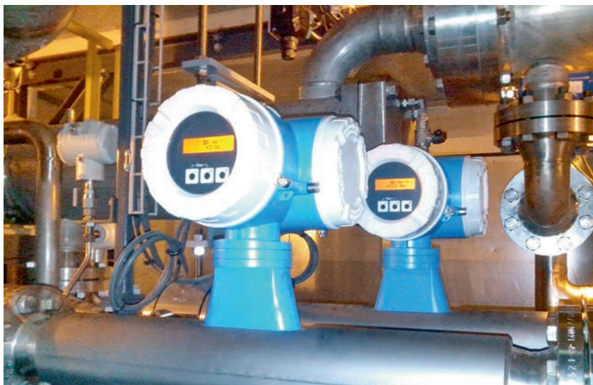
ФОТО 5. Узел учета компримируемого газа в компрессорных установках
