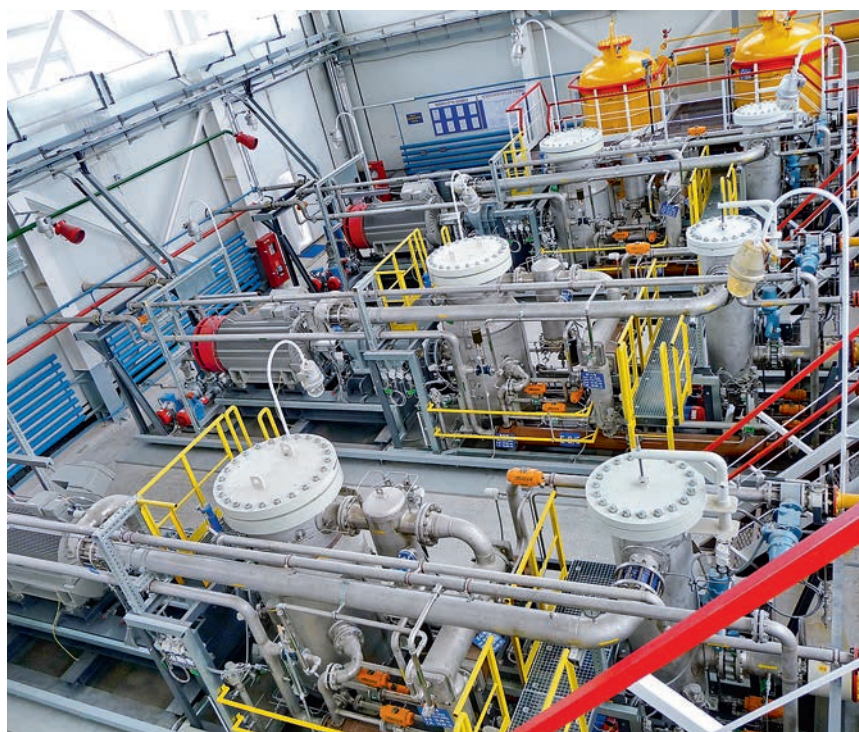
ФОТО 6. Дожимные компрессорные установки ангарного типа от компании ЭНЕРГАЗ снабжают попутным газом турбины ГТЭС Талаканского месторождения (Якутия)
