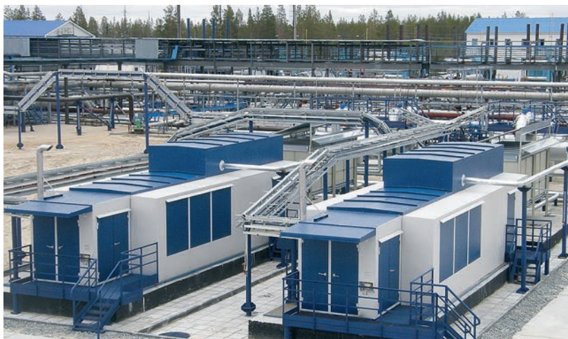
ФОТО 10. Вакуумные компрессорные установки «ЭНЕРГАЗ» работают на попутном газе с давлением 0,001 МПа
