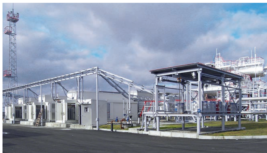
ФОТО 2. Биттемское месторождение ОАО «Сургутнефтегаз». Компрессорная станция для компримирования низконапорного ПНГ
