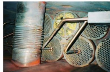
РИСУНОК 9. Обрыв трубы разводки
