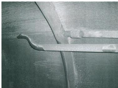
отложений и иных повреждений при осмотрах других важных элементов конструкции: кольцевых сепараторов, внутри которых проходят трубы отвода сепаратора (Рис.4), «дырчатых листов» – перфорированной цилиндрической стенки внутреннего корпуса всех четырех сепараторов; корпусов четырех сепараторов.
