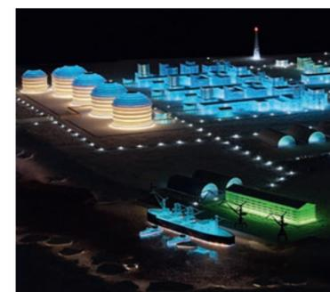
Проект второго завода НОВАТЭКа предусматривает строительство трех очередей по производству СПГ мощностью 6,6 млн т/год каждая на основаниях гравитационного типа.
