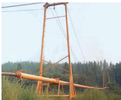
РИСУНОК 14. Переход СРТ ПМТП-150 через водную преграду на трассе нефтепровода «Ярактинское месторождение – пос. Верхнемарково»
