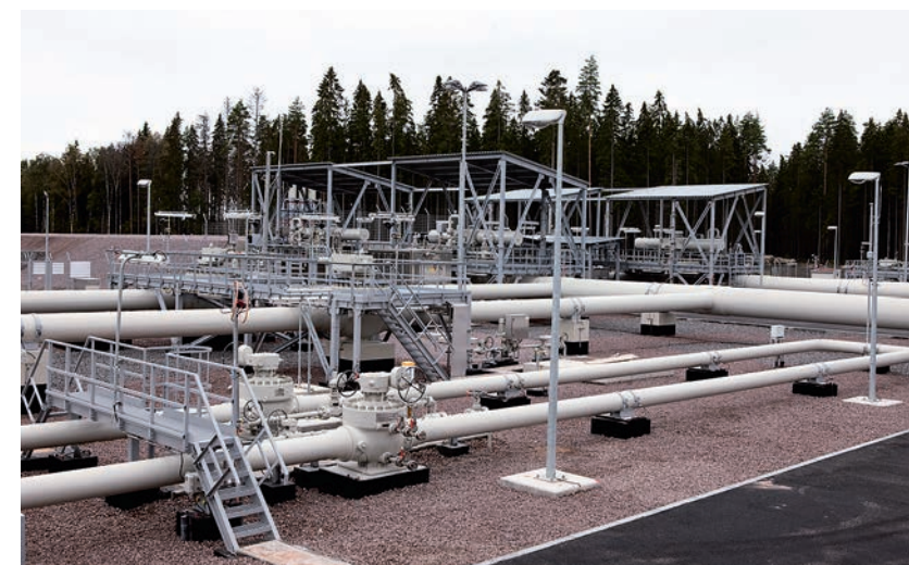
РИС. 3. Береговые сооружения в бухте Портовая
