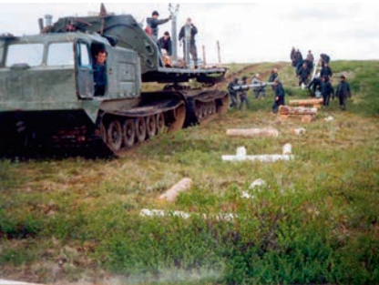
РИСУНОК 11. Раскладка и монтаж труб комплекта СРТ ПМТП-150 при прокладке нефтепровода «Мусюршор – Сандивей»
