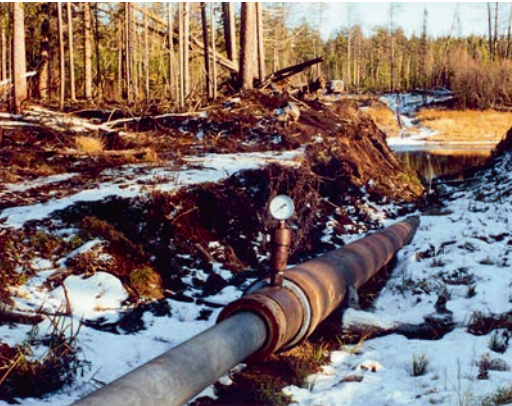
РИСУНОК 6. Переход СРТ ПМТП-150 через р. Пеледуй на трассе нефтепровода «Талаканское ГНМ – Витим»
