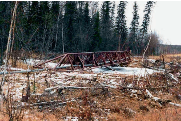
РИСУНОК 7. Переход СРТ ПМТП-150 через ручей на трассе нефтепровода «Талаканское ГНМ – Витим»
