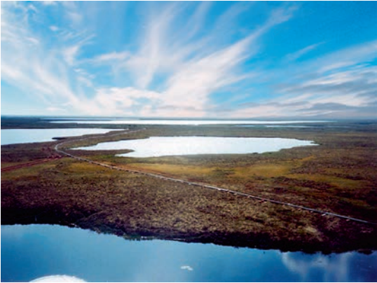
РИСУНОК 9. Сооруженный из труб комплекта СРТ ПМТП-150 нефтепровод «Мусюршор – Сандивей»
