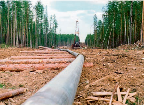
РИСУНОК 3. Сборно-разборный трубопровод ПМТП-150 на начальном пункте нефтепровода «Талаканское ГНМ – Витим»
