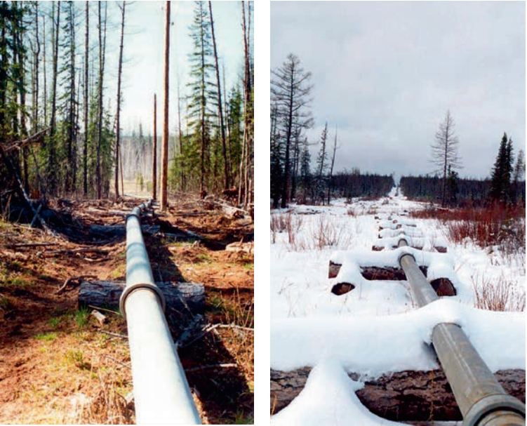
РИСУНОК 5. Сборно-разборный трубопровод ПМТП-150, проложенный на подкладках из бревен на трассе «Талаканское ГНМ – Витим»
