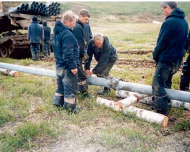
РИСУНОК 11. Раскладка и монтаж труб комплекта СРТ ПМТП-150 при прокладке нефтепровода «Мусюршор – Сандивей»
