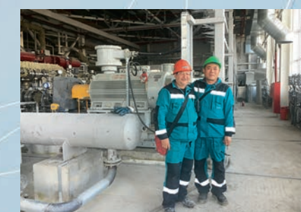
Сервис на площадке Сибур
