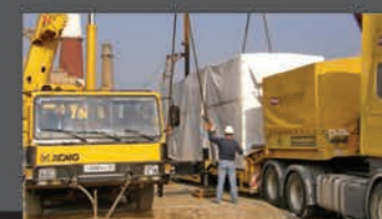
Доставка и монтаж
