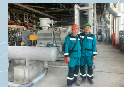
Сервис на площадке Сибур
